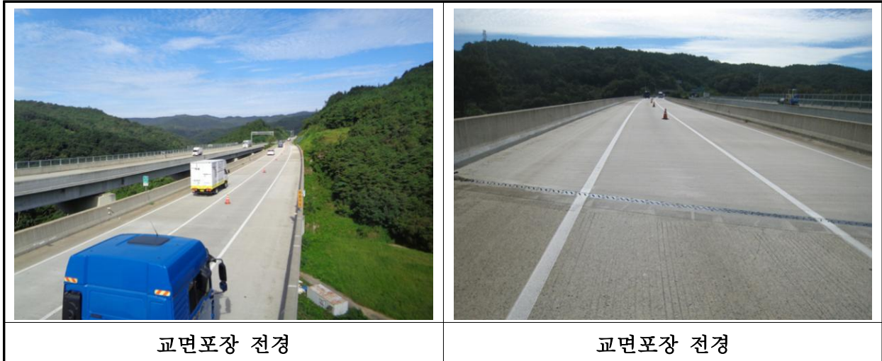
【사진 13.3.19】 교면포장 전경
