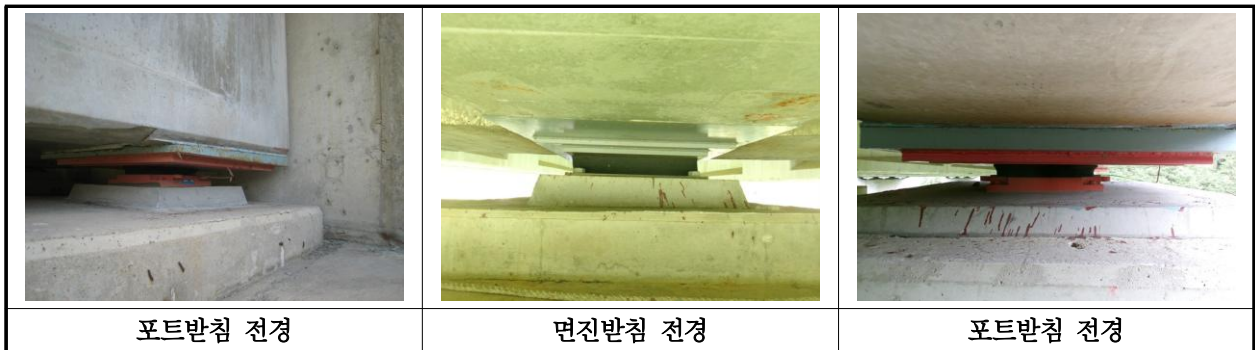
【사진 13.3.12】 교량반침 전경
