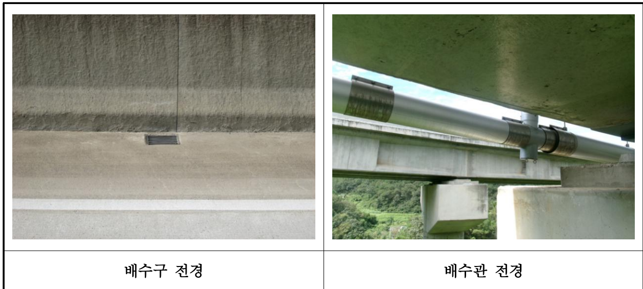
【사진 13.3.21】 배수시설 전경
