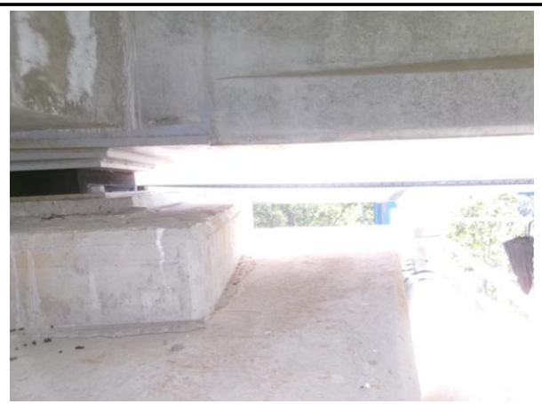
받침장치 연단거리 측정(2)
