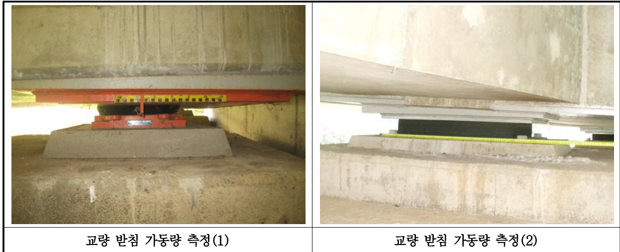
【사진 13.3.38】 교량받침 이동량 측정
