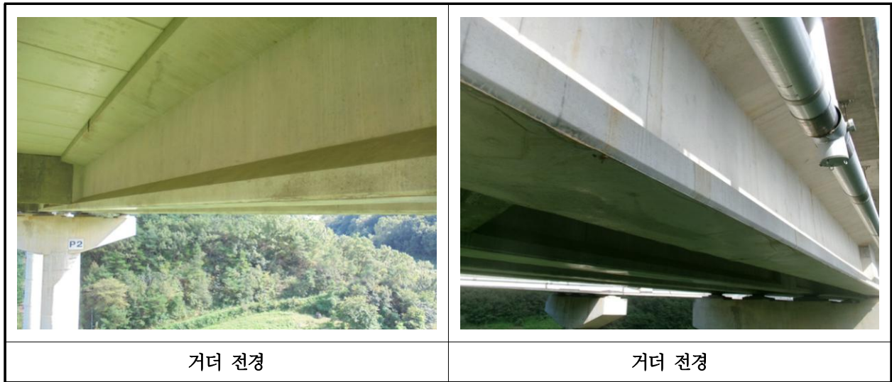
【사진 13.3.27】 거더 전경
