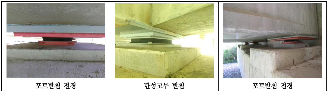
【사진 13.3.35】 교량받침 전경
