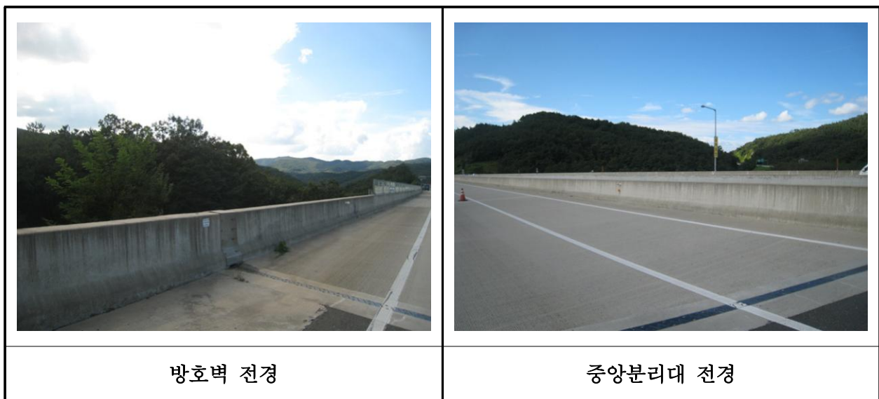
【사진 13.3.48】 방호벽 및 중앙분리대 전경
