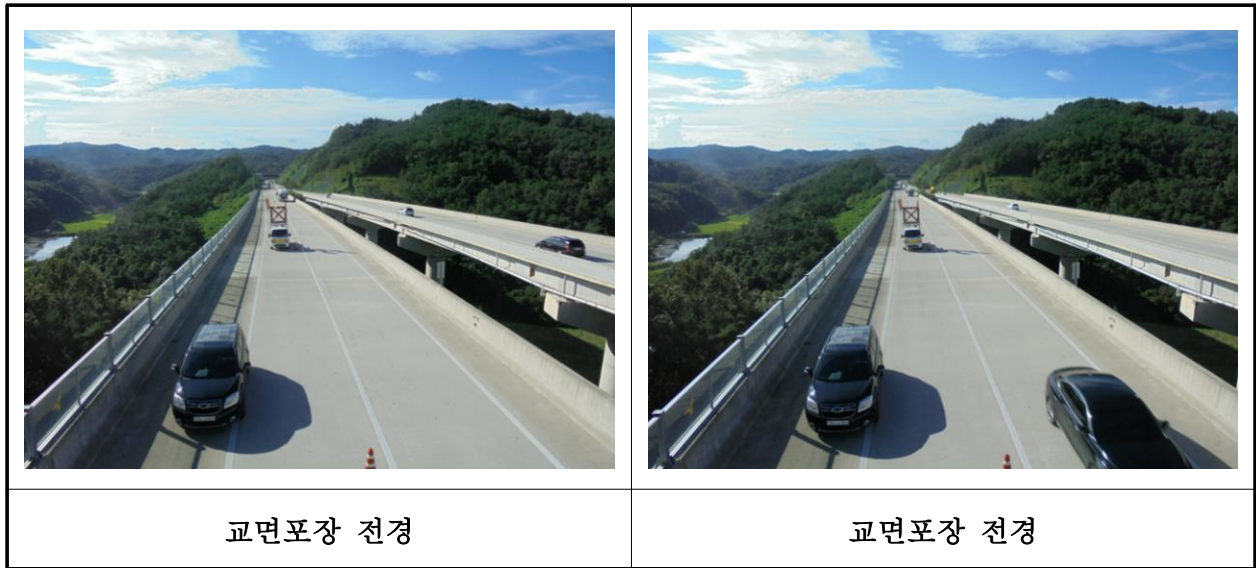
【사진 13.3.44】 교면포장 전경
