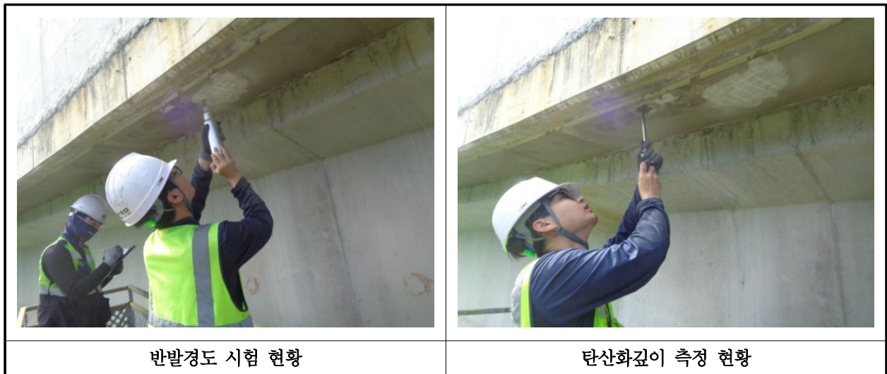
【사진 13.4.1】 콘크리트 내구성조사 현황
