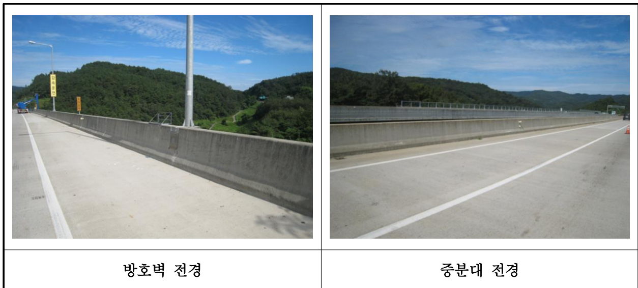
【사진 13.3.23】 방호벽 및 중앙분리대 전경
