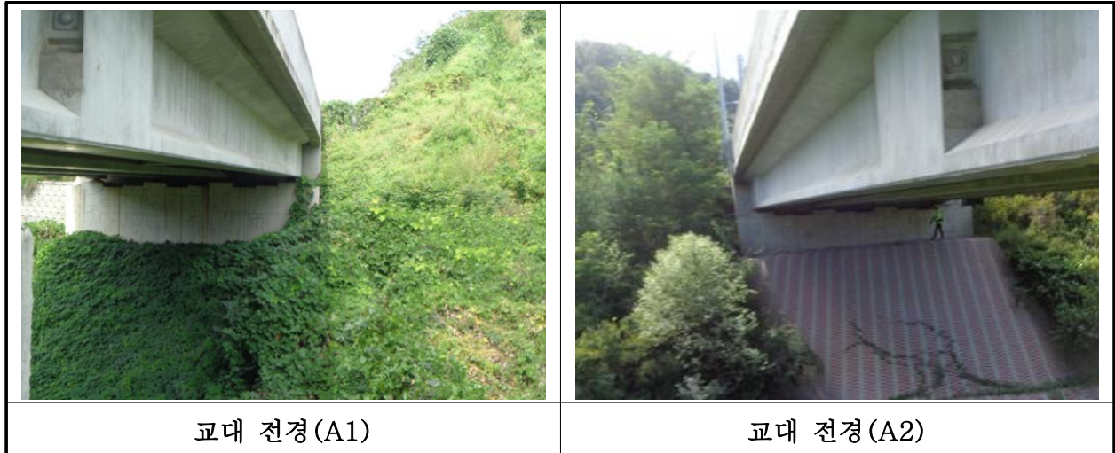
【사진 13.3.8】 교대 전경
