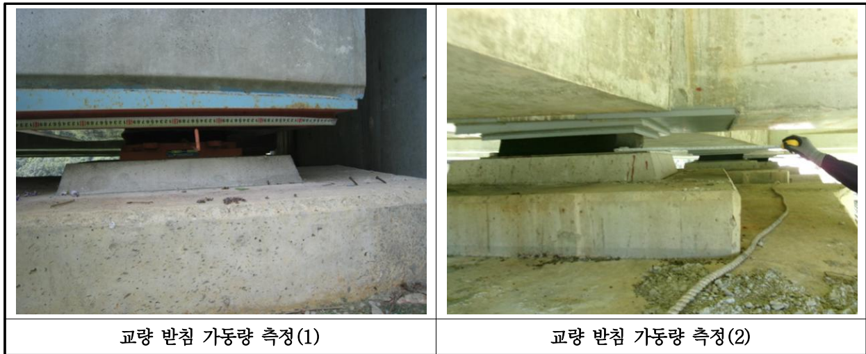
【사진 13.3.15】 교량받침 이동량 측정
