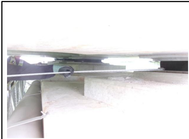
받침장치 연단거리 측정(1)
