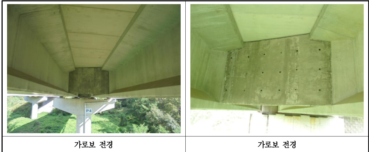
【사진 13.3.29】 가로보 전경
