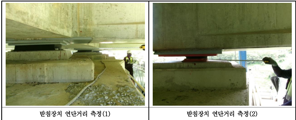
【사진 13.3.14】 교량받침장치 연단거리측정
